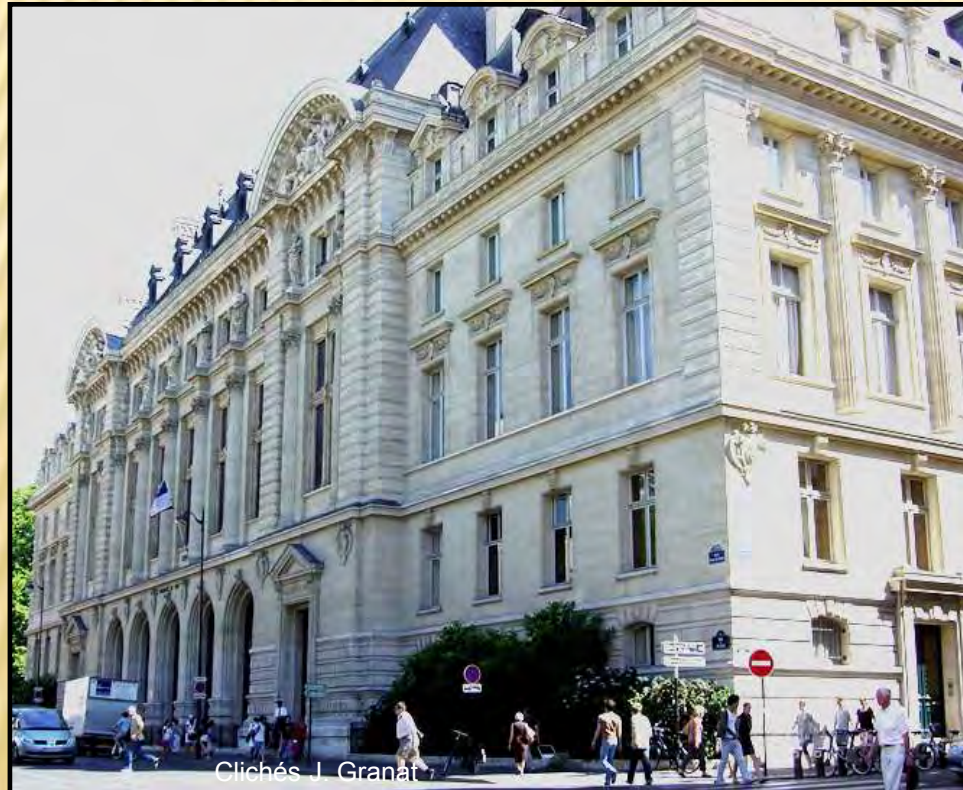
Vue de la rue des Ecoles
