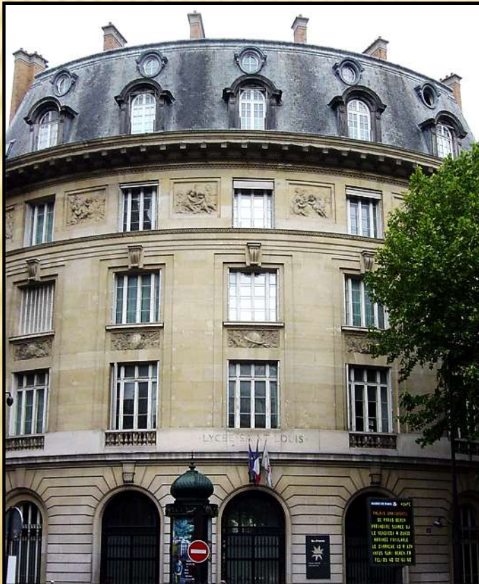
Entrée principale façade boulevard Saint-Michel
